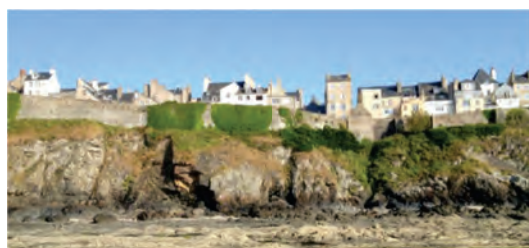
Falaises soumises à érosion littorale (Granville)
